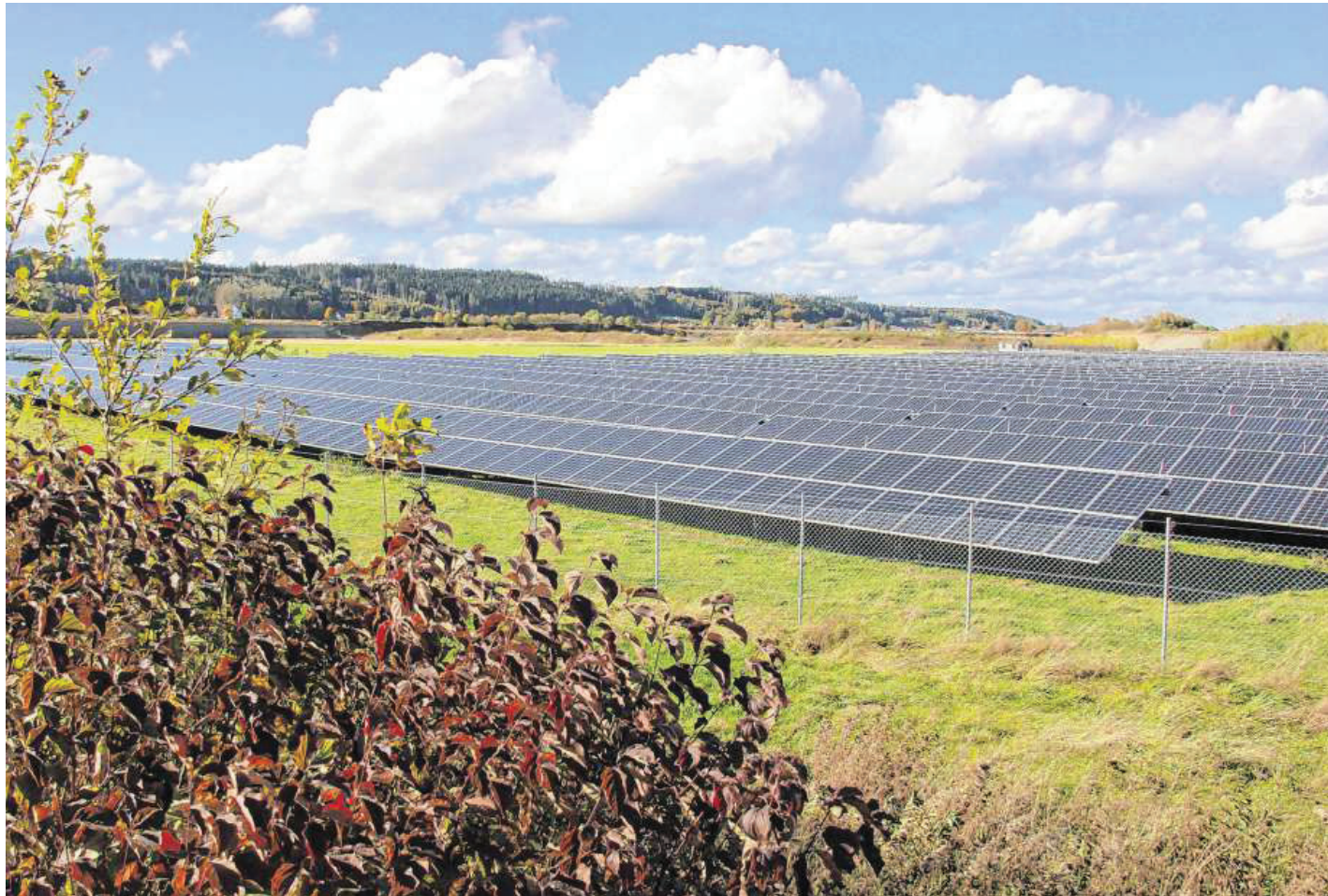
Die Photovoltaik-Anlagen der Firma Allgäu Kies bei der Kiesgrube im Darast.
